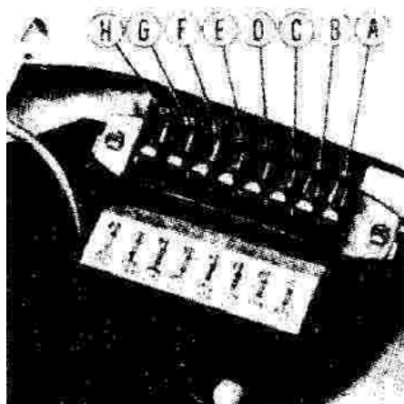
Obr. 7.28 Pohled na odkrytou pojistkovou skříňku
